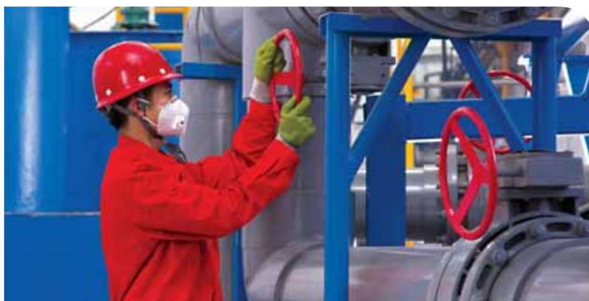
三層過濾處理廢水
